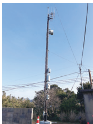
（納島）新たに建柱した マイクロ無線等施設
