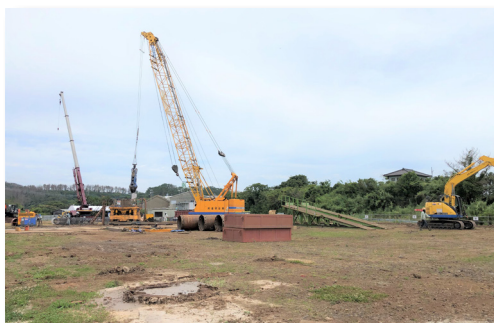
工事が進む新診療所（撮影／6月30日）
