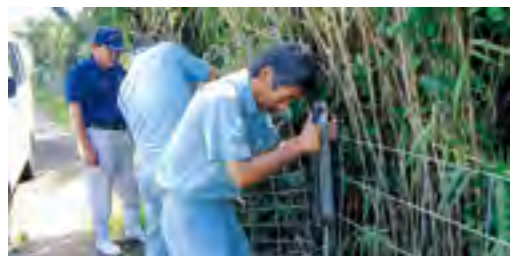
ワイヤーメッシュの設置作業
