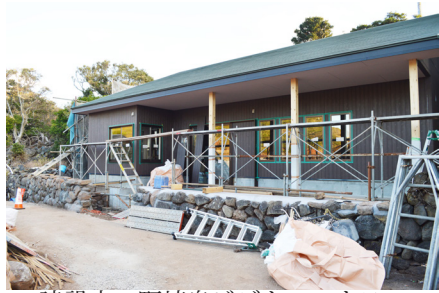
建設中の野崎島ビジターハウス
