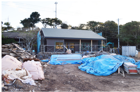
野崎島に建設中のビジターセンター
