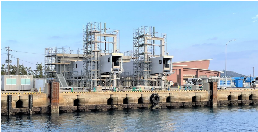
現在、外装及び内装の仕上げ中
