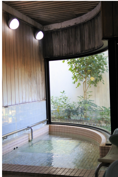
浴室や多目的室の改修工事です
