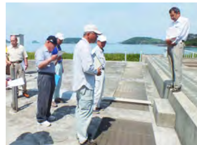
下水道施設を視察し説明を受ける産業建設常任委員会
