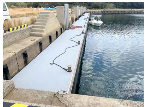
簡易浮栈橋補修工事
