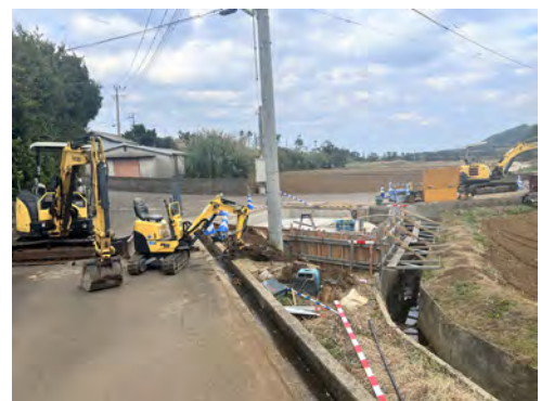
防火水槽改良工事
