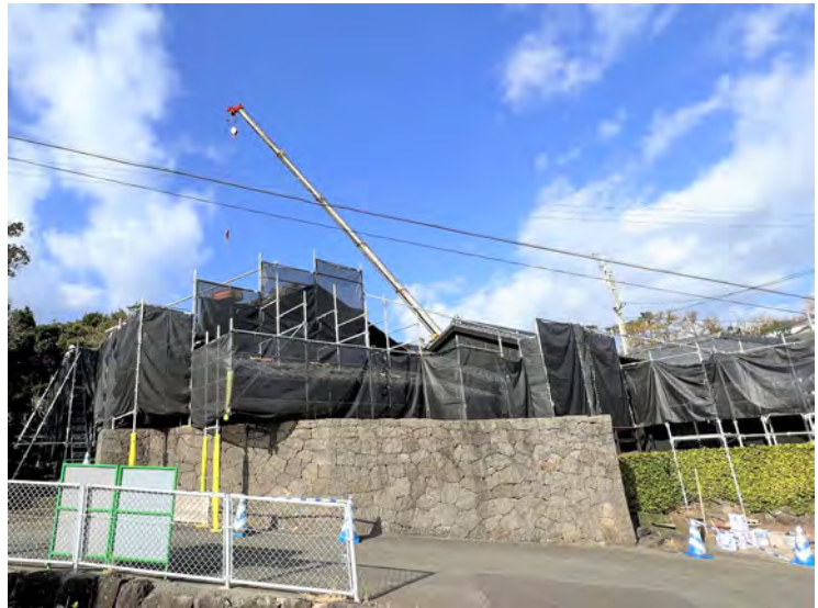
古民家まつなが邸屋根替工事
