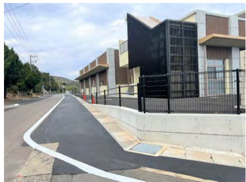
診療所歩道改良工事
