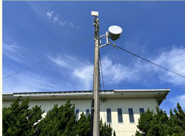
し尿処理場の大島を見通せる電柱に設置
