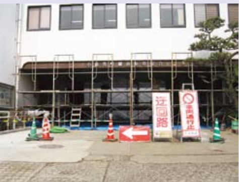
離島開発総合センター耐震工事
