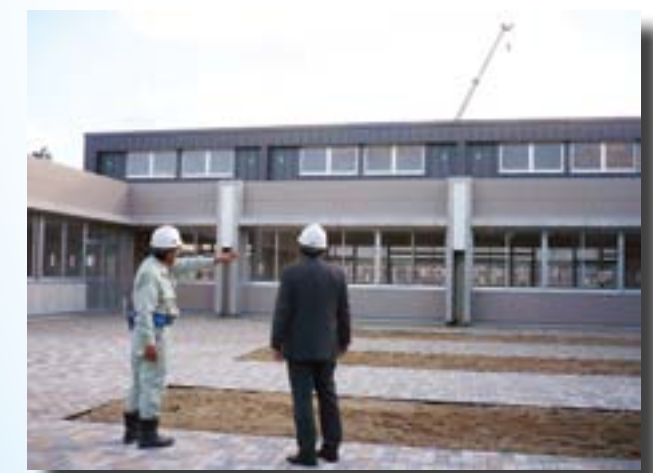
建設中の新校舎
