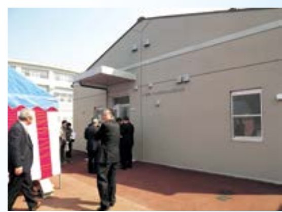
完成した小中学校給食合同調理場
