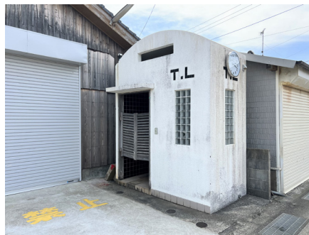
1分団詰所横（西町公園前）のトイレ
