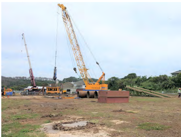
想定外の岩盤の硬さで難航した杭工事
