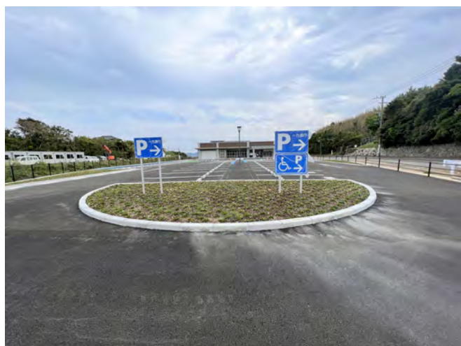
駐車スペースはたっぷり 場内は一方通行
