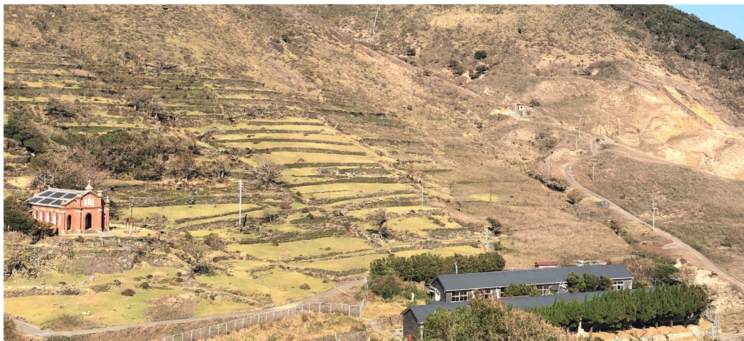
旧野首教会 階段下～水道施設下が無電柱に
