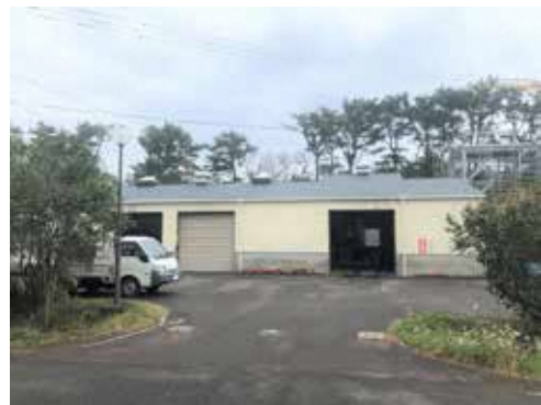
ストックヤード補修
