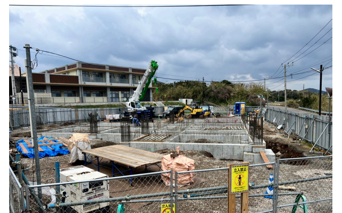
現在は基礎工事をしている、完成が楽しみだ
