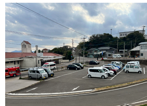
施工前は旧診療所駐車場だった
