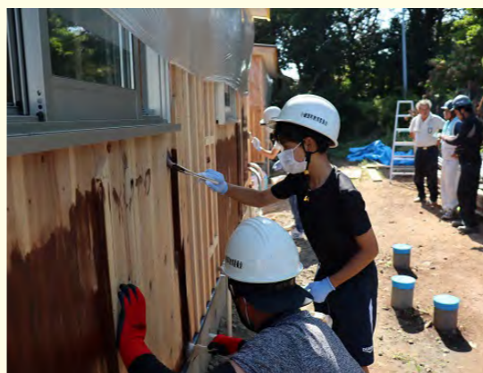
「ちかまる寮」の外壁塗装には寮生も関わった
